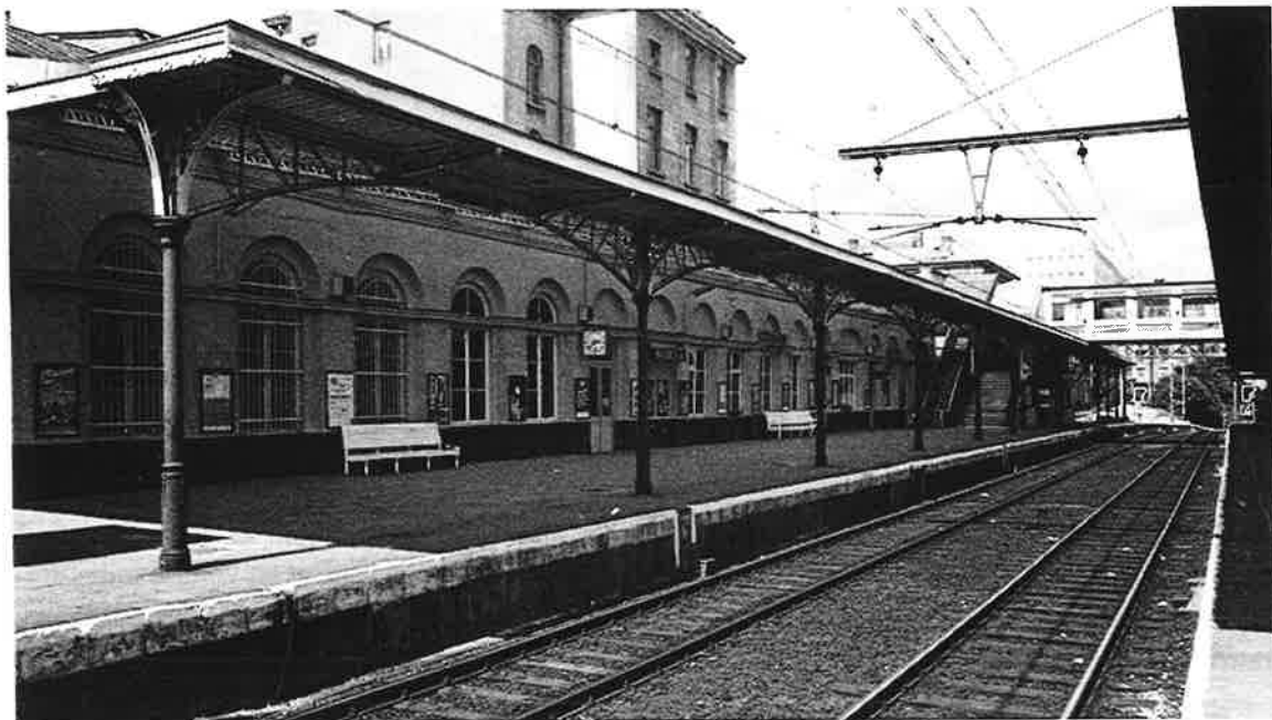
Marquise et quai de la voie 1
