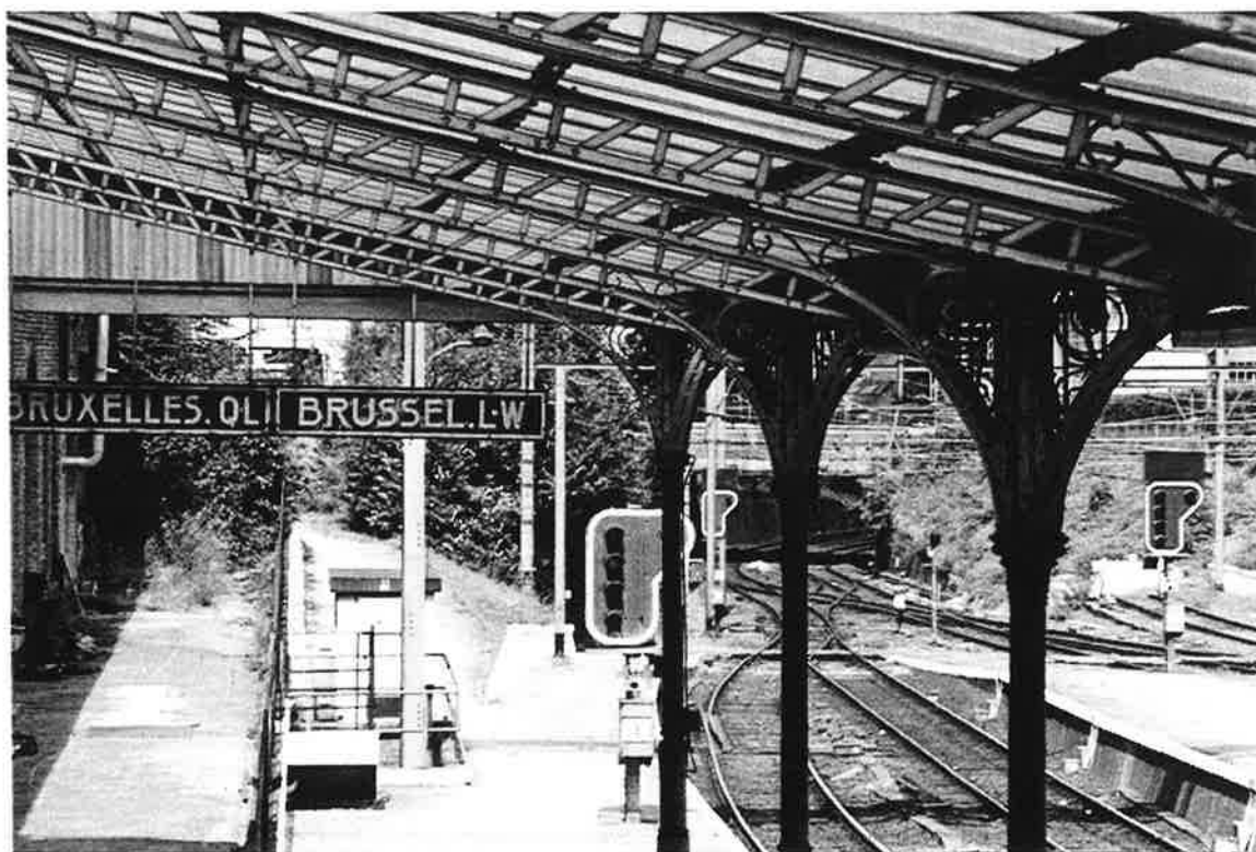
Vue sous la marquise de la voie 1 vers la rue Beillard. La voie 1 étant rarement utilisée, remarquez le dispositif de sécurité à la hauteur du signal au rouge. Existe aussi sur la ligne 185 (ligne industrielle à Engis)
